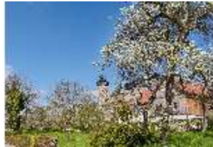
SaZwe.I, Fassade von Süd- Osten, DI007808, BSV-
