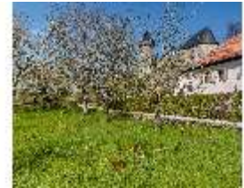
SaZwe.I, Fassade von Süd- Osten, DI007816, BSV-
