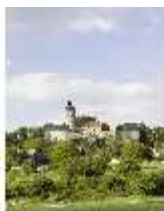
SaZwe.I, Burgfassade, Blick von Süden, DI008239, BSV-
