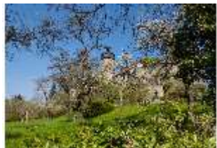
SaZwe.I, Fassade von Süd- Osten, DI007813, BSV-
