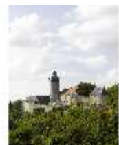
SaZwe.I, Burgfassade, Blick von Süd-Osten, DI008238, BSV-
