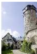
SaZwe.I, Kapellenhof, Kapellenbau und Bergfried, DI008235, BSV-
