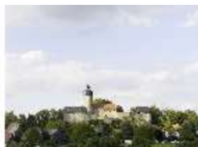
SaZwe.I, Burgfassade, Blick von Süden, DI008240, BSV-
