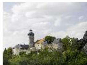
SaZwe.I, Burgfassade, Blick von Süd-Osten, DI008237, BSV-
